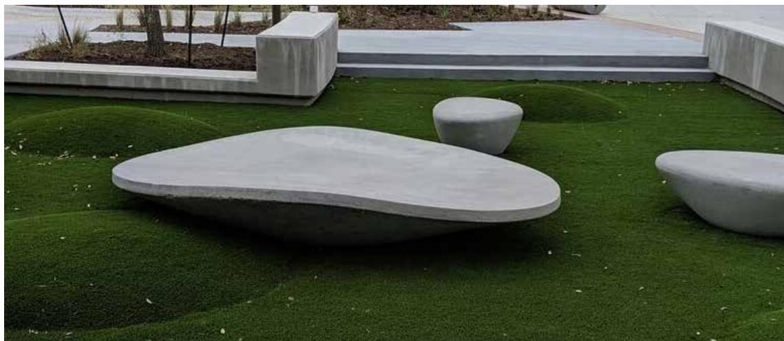
FR - Banc en béton coloré en masse, decapé et imperméabilisé.
